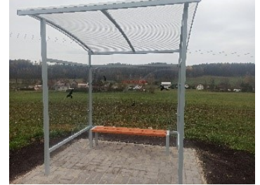
Podloží k zastávce „Dolní Lhota
