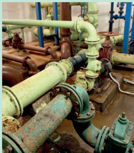
Stávající stav vodojem
