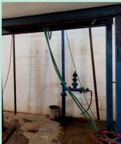
Demontáže potrubí - nádrž vodojemu
