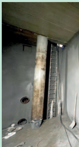
Sanace nádrže vodojemu
