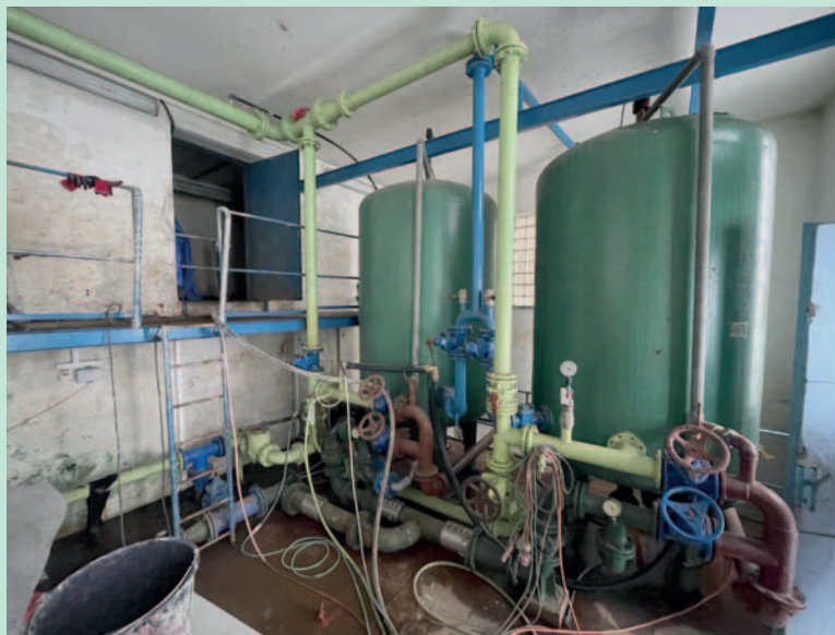
Úpravná vody 1. NP_příprava k demontáži
