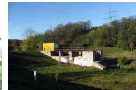
ZADRŽOVÁNÍ POVODNĚ SUCHÉ NÁDRŽE
