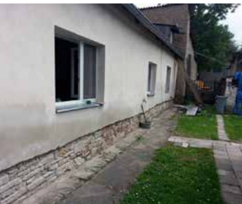
Odstraňte venkovní omítku soklu a nepropustný okapní chodníček pro lepší vysychání stavby.
