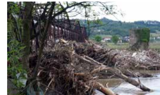
Zachycené dřevo na mostě působí jako překážka a může lokálně zhoršit povodeň.
