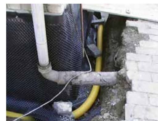
Drenážní trubka před zásypem štěrkem.
