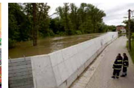
STRUKTURÁLNÍ PROTIPOVODŇOVÁ OPATŘENÍ PEVNÉ VALY A ZDI
