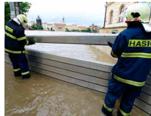
Mobilní hrazení je náročné na logistiku a je potřeba ho postavit včas.
