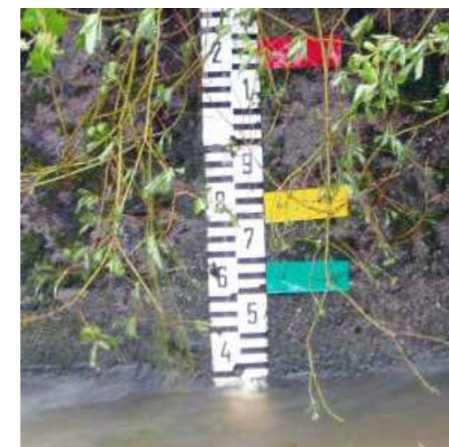
Vodoměrná lať s vyznačením stavů odpovídajících jednotlivým stupňům povodňové aktivity.
