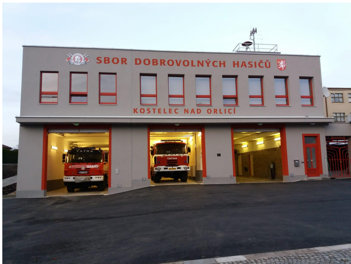
Fotografie po realizaci stavby 28.11.2019
