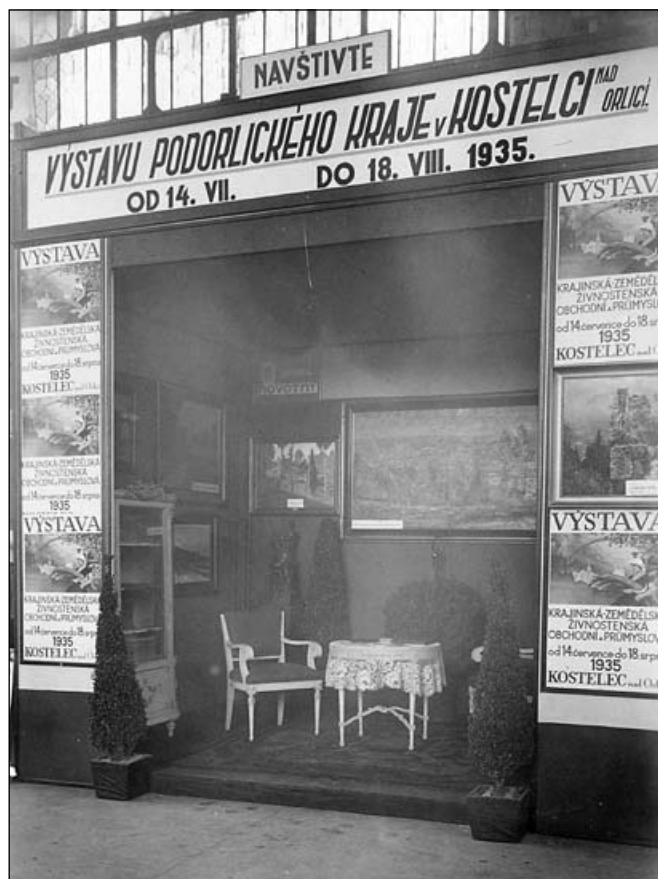
Pohled na vchod do jednoho z pavilonů.
