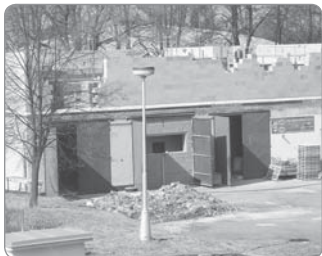
1. 12. března jsou rozestavěné obvodní zdi.
