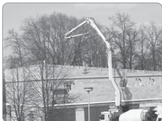
3. 5. 4. Opět s touto technikou je zaléván již šikmý betonový věnec se zápuškami pro dva základní vazníky krovu.
