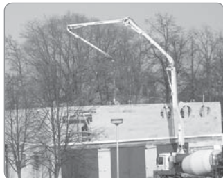
2. 20. 3. Jsou již vidět tři kulaté otvory pro okna směřem do stadionu a zalévá se s pomocí moderní techniky stropní věnce stavby.
