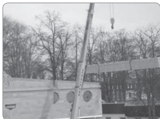
4. 11. 4. Hned po ránu již automobilový jeřáb pokládá do připravených kapes motuťné příčné vazníky.
