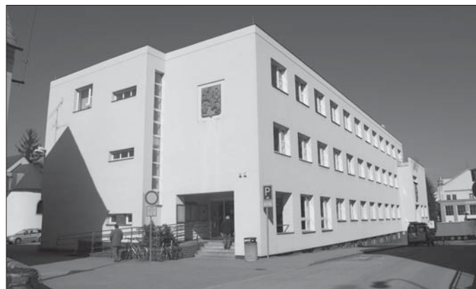
Budova MěÚ s hlavní pokladnou
