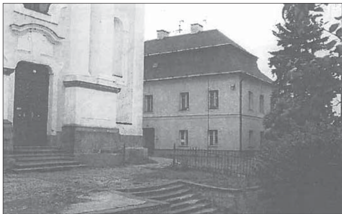
První školní budova nového věku z konce 18. stol.. Později dívčí škola.
