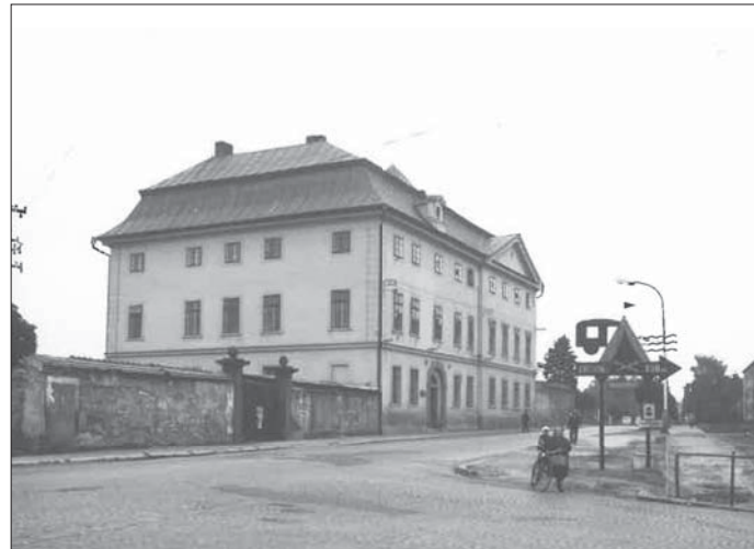
Foto: Starý zámek před rekonstrukcí
