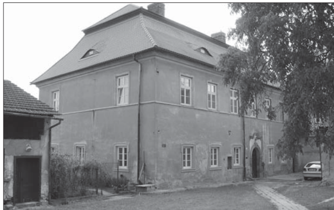
Foto: Objekt fary s obnovenou střechou a okny s ostěním
